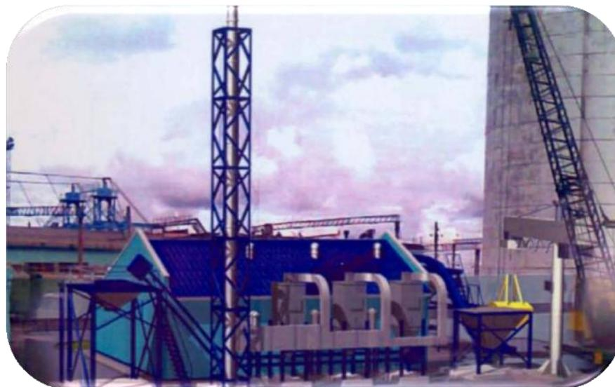
Котельная КТУ-3 на твердом топливе (каменный уголь) мощностью 3 Гкал/ч (станция Арышта-2 Кузбасского отделения ЗСЖД)
